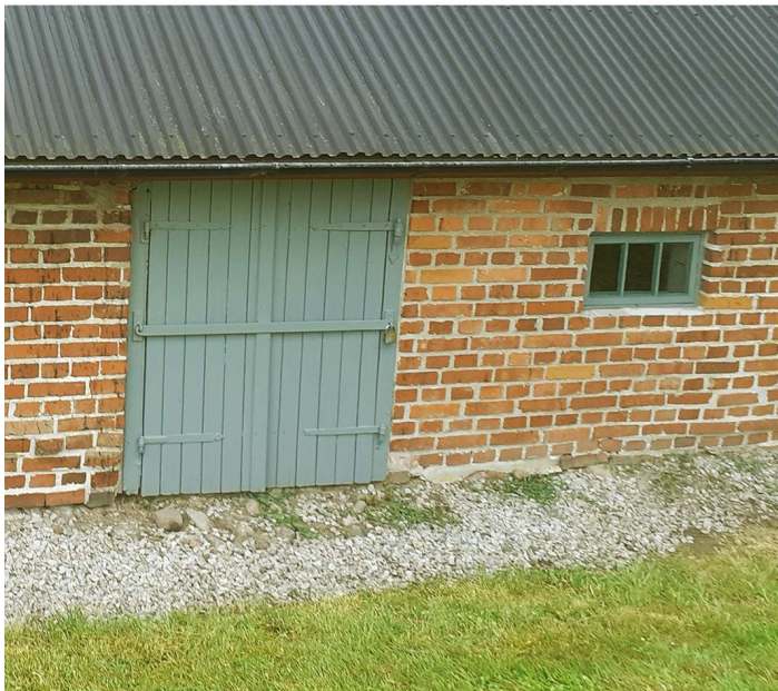
Stallets vägg mot kvarnen efter renovering
