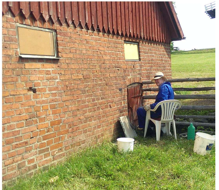
Allt trä målades och teglets dåliga fogar fogades om
