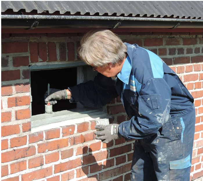
De gamla fönsterkarmarna målas
