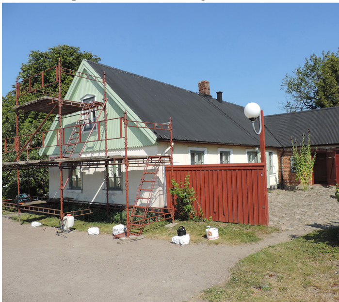
Gavelspetsen är målad med hjälp av ställning
