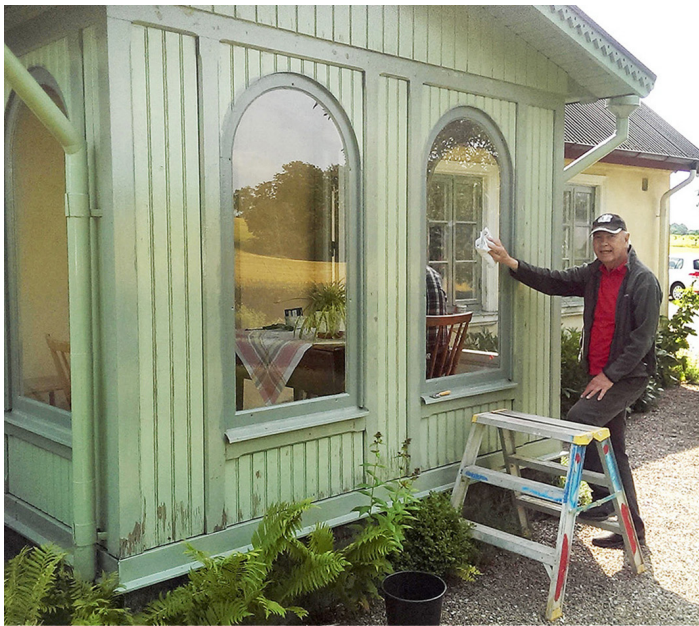
Fönsterna putsas innan fönstergallerna återmonteras
