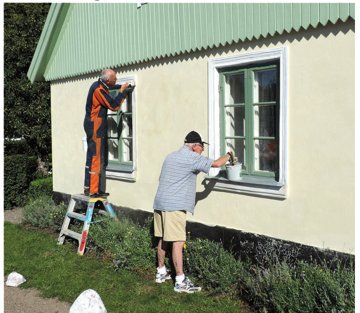
Listverket runt fönsterna målas vita
