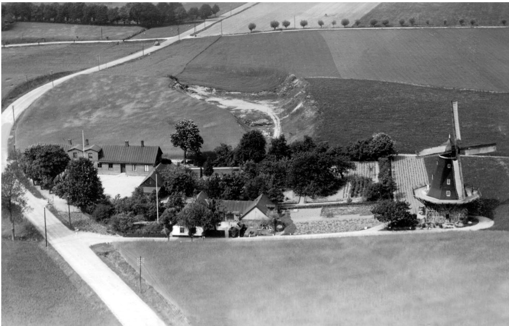
Flygbild över Aggarps kvarn och skola, däremellan möllarebostaden. Vyn är idag i stort sett densamma. Kvarnen byggdes 1896 och togs ur drift 1951. Skolan byggdes 1877 och lades ner 1955. Möllarebostaden och kvarnen ägs numera av Svedala kommun.
