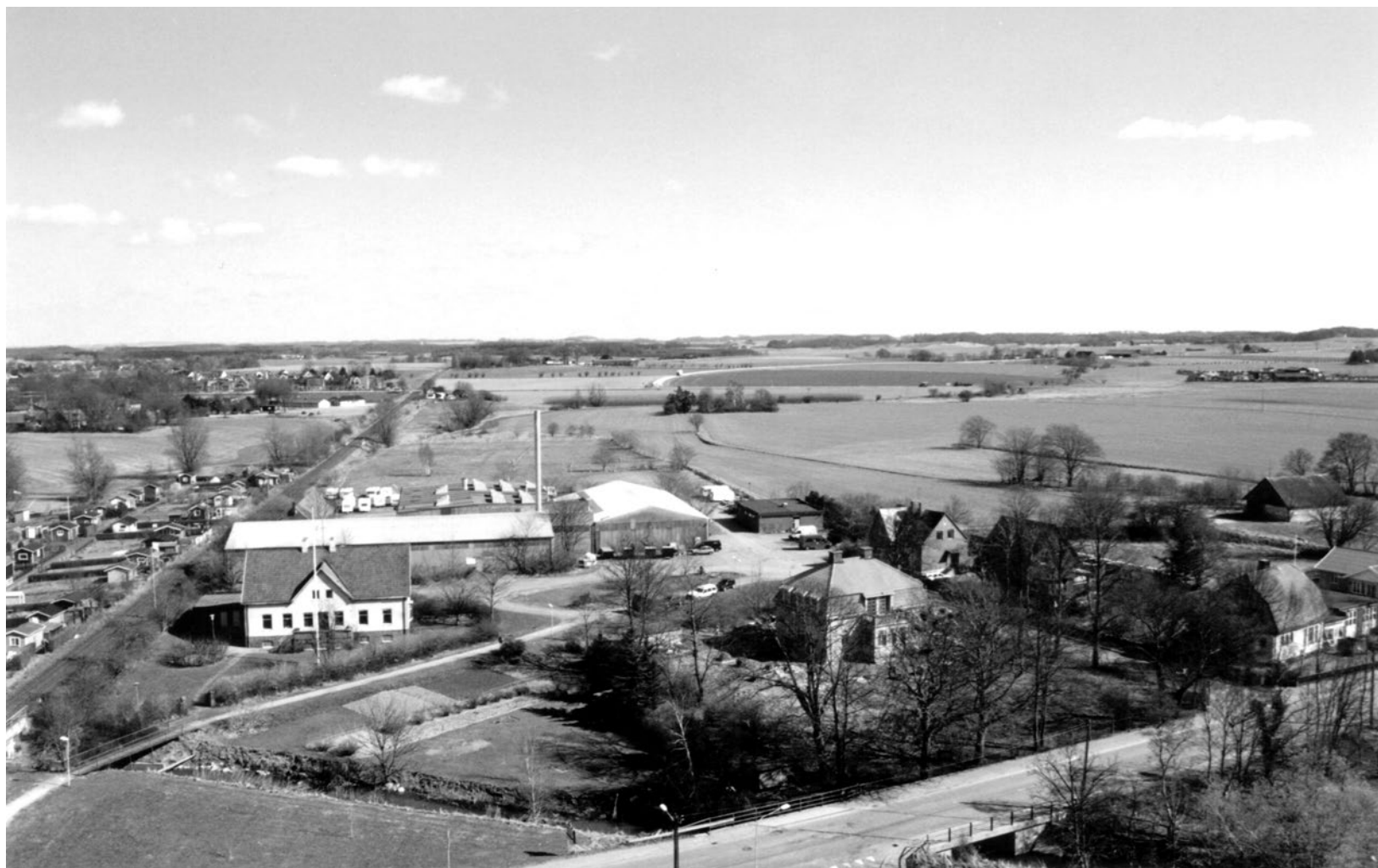
Tegelbruksområdet idag. Bilden tagen från Lantmännens silobyggnad som revs sommaren 2003. Under hösten 2003 inleddes nybyggnationen av bostäder på området, en ny "stadsdel" i Svedala, söder om järnvägen. Cirka 1000 personer beräknas bo på det nya området. Till vänster på bilden ses Tegelmästarskolan och till höger ligger "Gustaf Berns villa", numera pietetsfullt renoverad.
