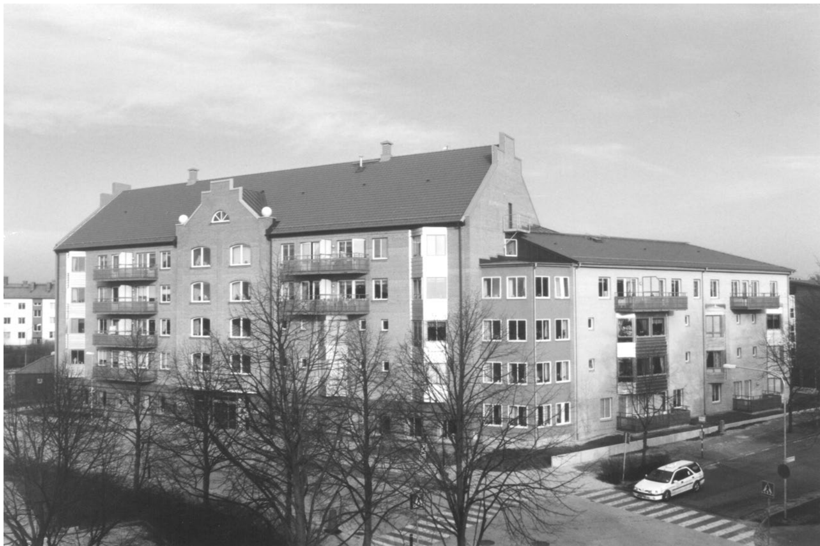
Det nybyggda femvåningshuset för serviceboende i kvartellet Stella, på den gamla läkarvillans tomt. Huset invigdes 2002 och är idag Svedalas högsta bostadshus.
