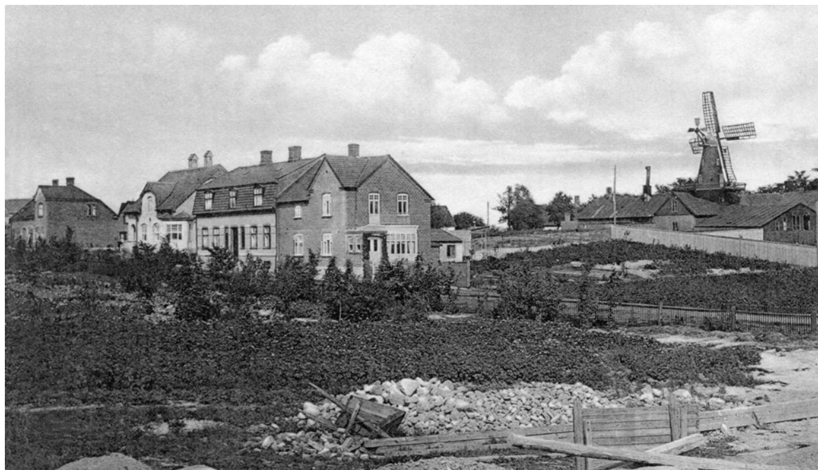
Utsikt över blivande Floraparken, bort mot Parkgatan. På höjden syns "Fittamöllan". I förgrunden ses brandstationen under byggnad, bilden är således från 1913.
