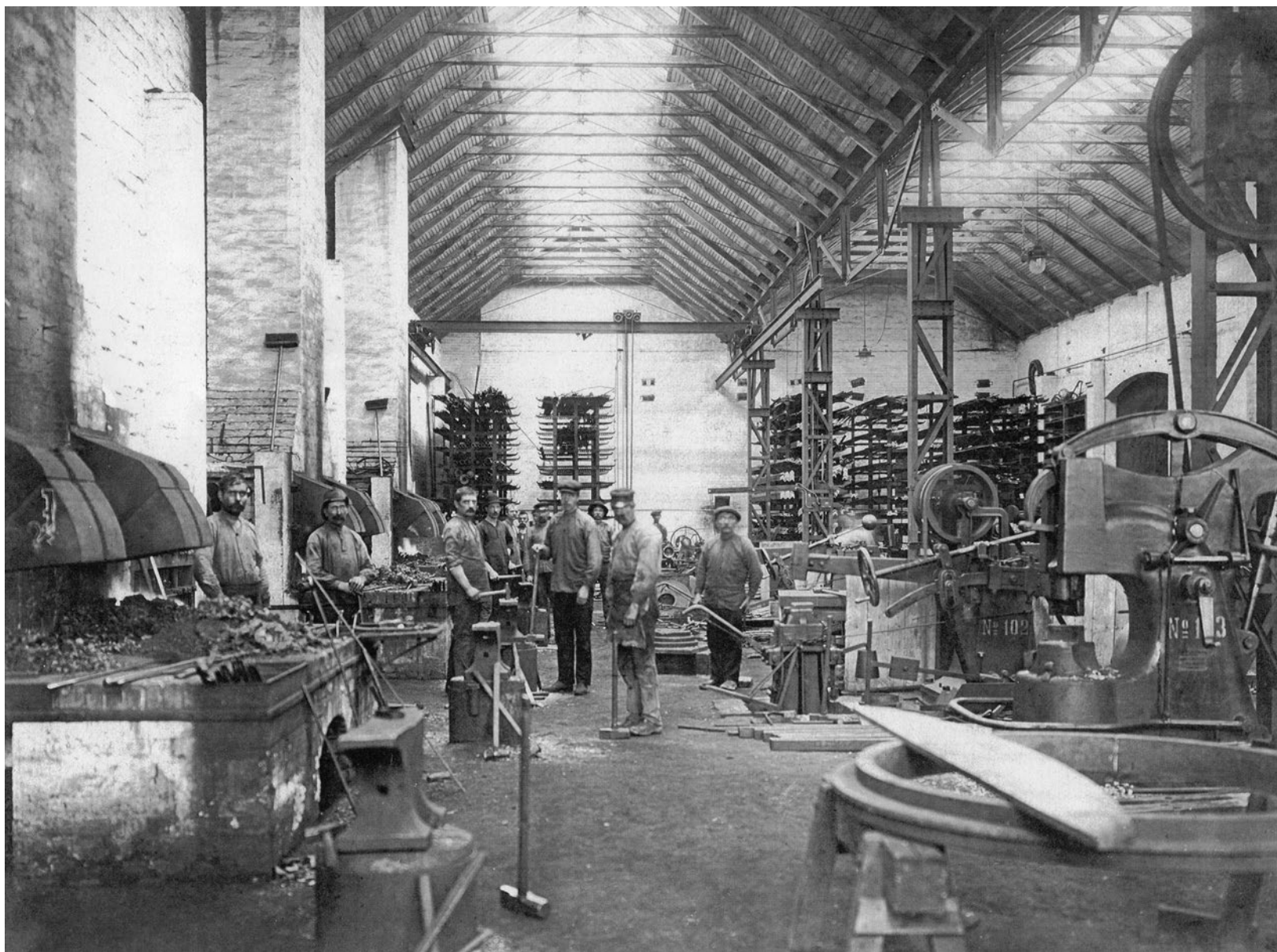
Smidesverkstaden med ässjorna. Till vänster ses skorstenarna, som också dominerar gatufasaden.
