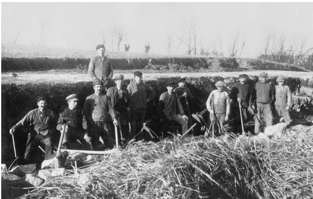
Vägarbetare vid byggandet av Norr- skogsvägen, troligen som ett beredskaps- arbete på 1930-talet.
