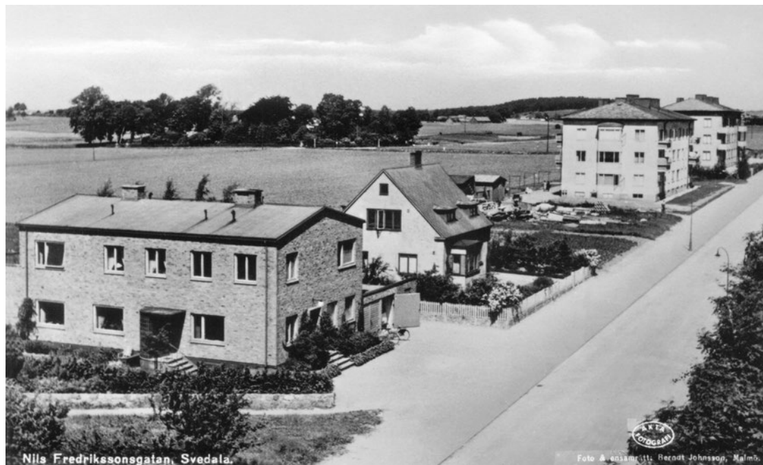
Nils Fredrikssongatan kring 1940. I förgrunden ses den nybyggda läkarvillan med bostad och mottagning för den förste provinsialläkaren, doktor Lenninger. Längst bort ligger Högbo, byggt 1937. Mellan detta och läkarvillan ligger Solgården från 1939.
