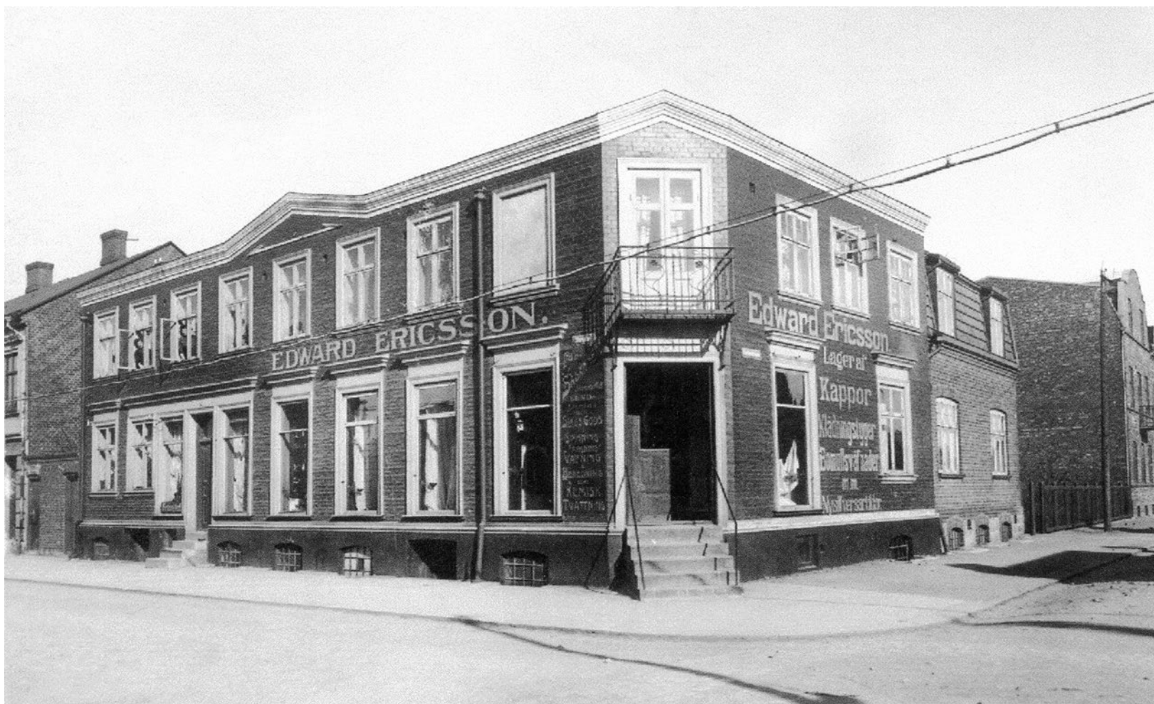
Hörnhuset Storgatan-Hantverkaregatan i början av 1930-talet. Det är faktiskt samma hus som står där än idag, om än kraftigt ombyggt.
