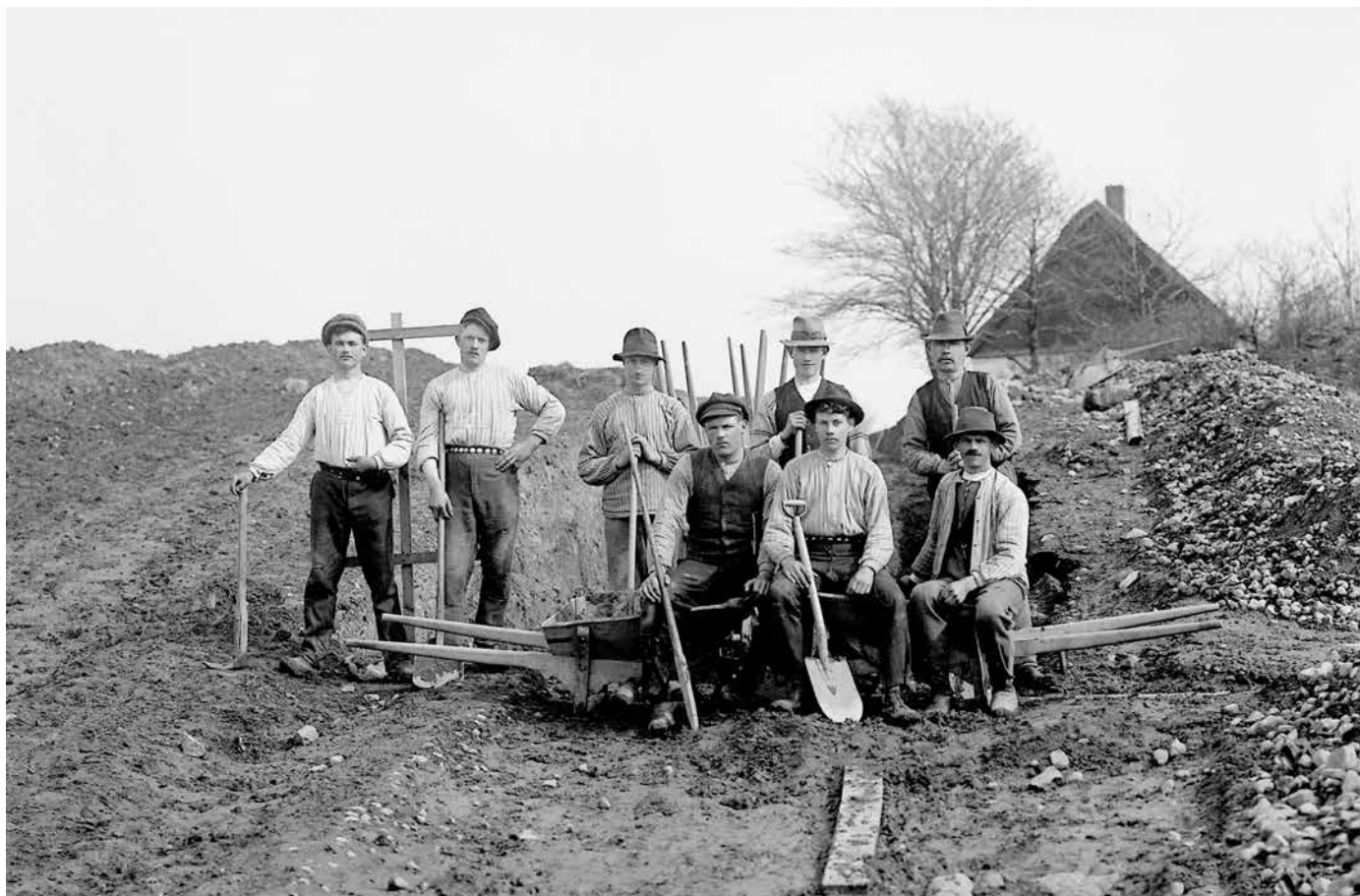
Vägarbete med enkla redskap: hacka, spade och rullebör. 2:9-2-15
