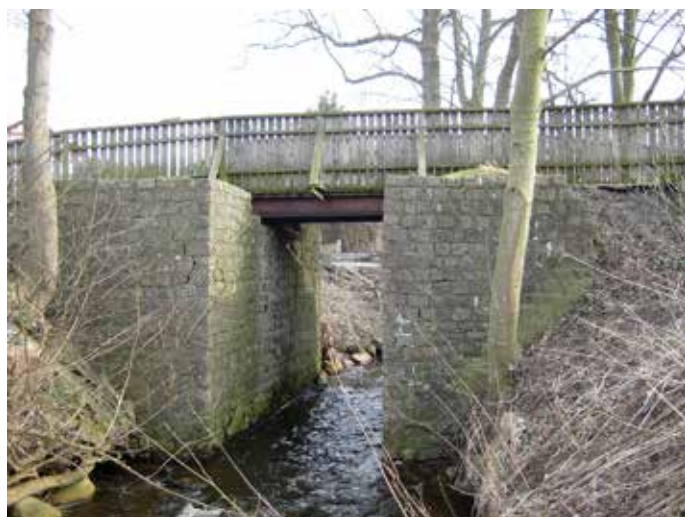
Järnvägsbron till saftstationen i Klågerup, 2013
