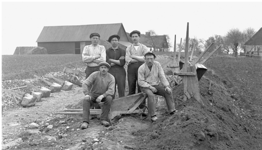
Vägarbete med enkla redskap: hacka, spade och skottkärra (rullebör).
