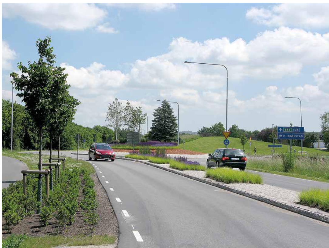
Hylltarpsvägen idag, efter ombyggnaden
