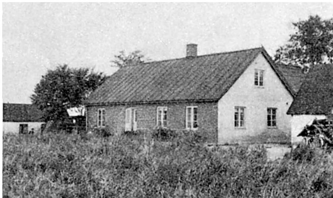
I detta hus i Sturup fanns en handelsbod innan det blev bostad åt smeden Alfred Malm.
