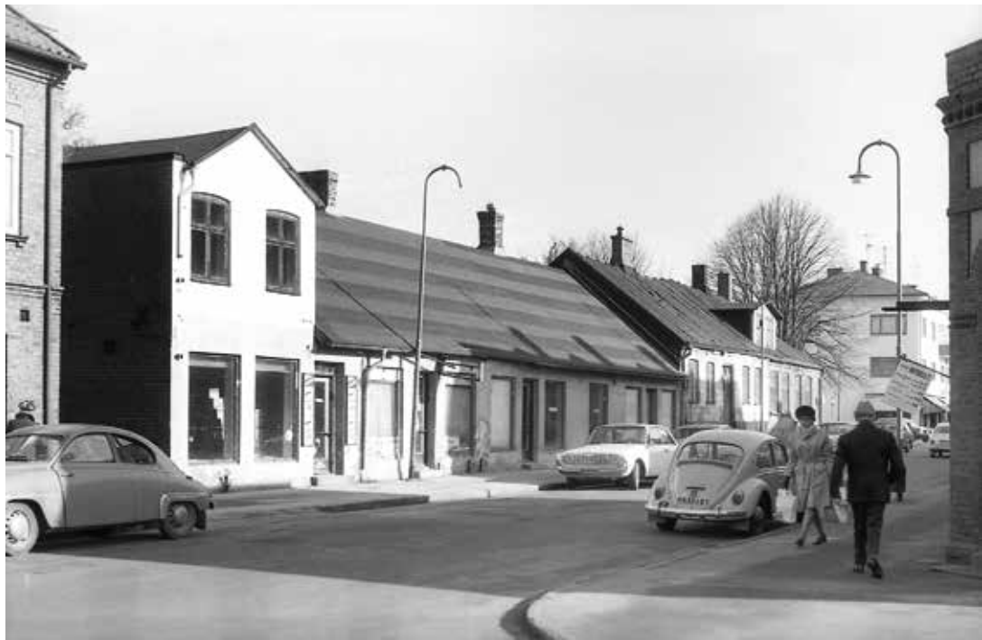
Storgatan 23 – en sista bild före rivningen.
