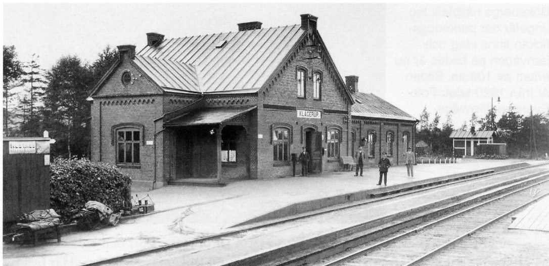
Klågerups station 1905 efter ombyggnaden sedan Malmö-Genarpsbanan tillkommit. Den högra delen är det ursprungliga stationshuset.
