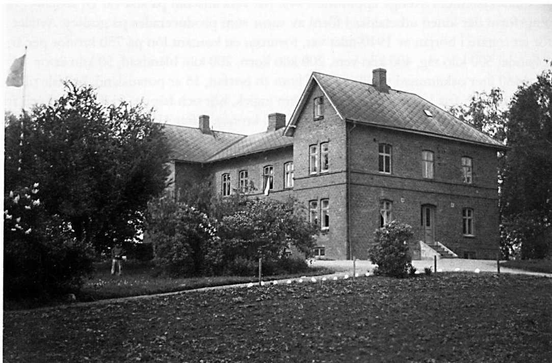
Bostadshuset vid saftstationen som även det kallades för ”saftstationen”.
