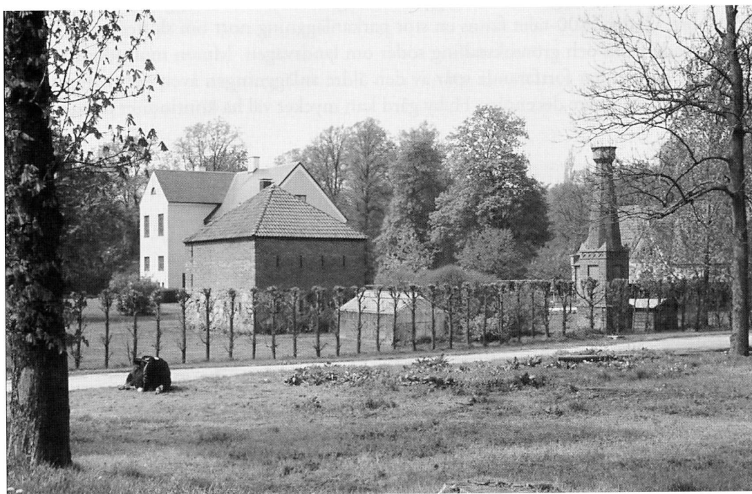
Nuvarande huvudbyggnad vid Hybygård är enkel efter en omfattande ombyggnad 1966. Intill ses den unika storkpelaren som ritades av Helgo Zettervall och uppfördes på 1880-talet.
