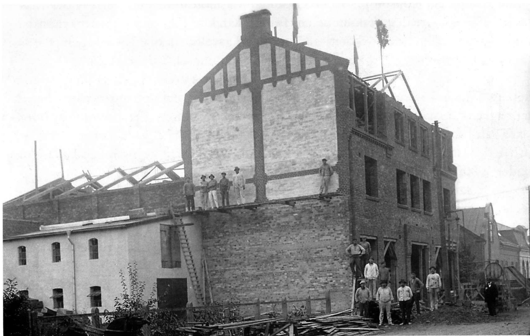
Tid för taklagsfest när biografen byggs 1919.
