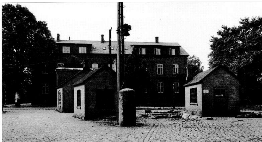
1930 noterades som en stor nyhet att fabrikskontor, laboratorium och bostäder förses med värmeledning. Bilden visar kontorsbyggnaden med vaktstugor in mot bruket. De två nedre planen används fortfarande som kontor för den centrala verksamheten.
