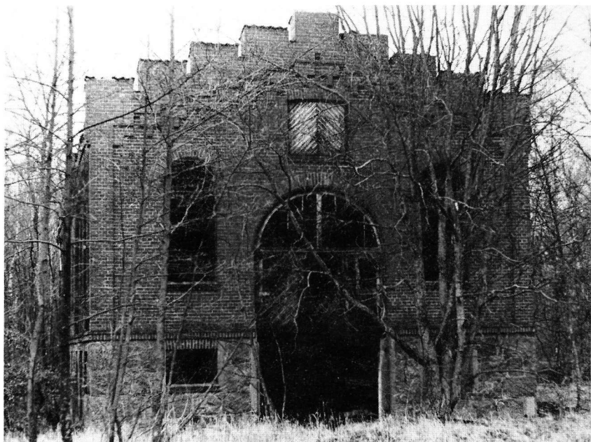
Slätteröds kraftstation lades ned 1922. Den fungerade därefter in på 1950-talet som transformatorstation. I dag ligger "kraftkatedralen" öde, helt dold bland den spirande lövskogen. — Foto: Hans Norling.
