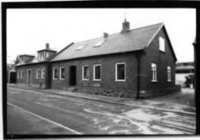
Hus 1, fasad mot Bankgatan
