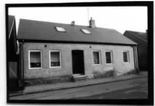
Hus 1, fasad mot Bankgatan
