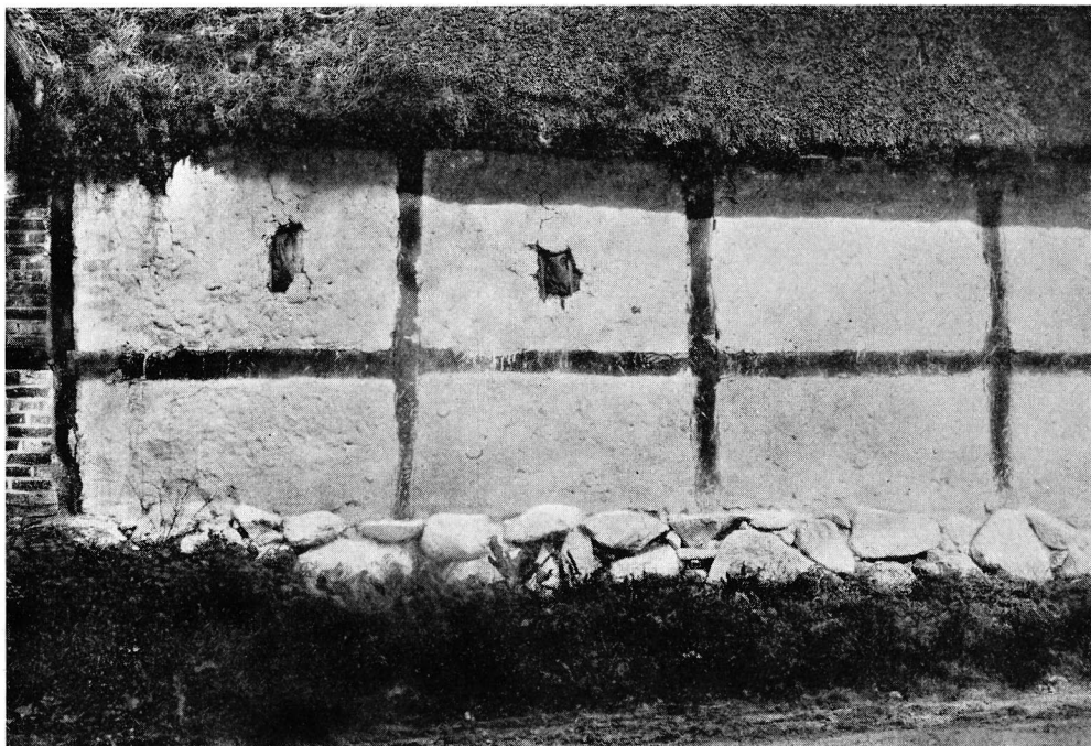
Korsvirkesvägg med lerklining på stakar. Obs.! Stolparna äro satta på grunden utan fotträ. Gluggarna äro ljusluggar intill logan.
