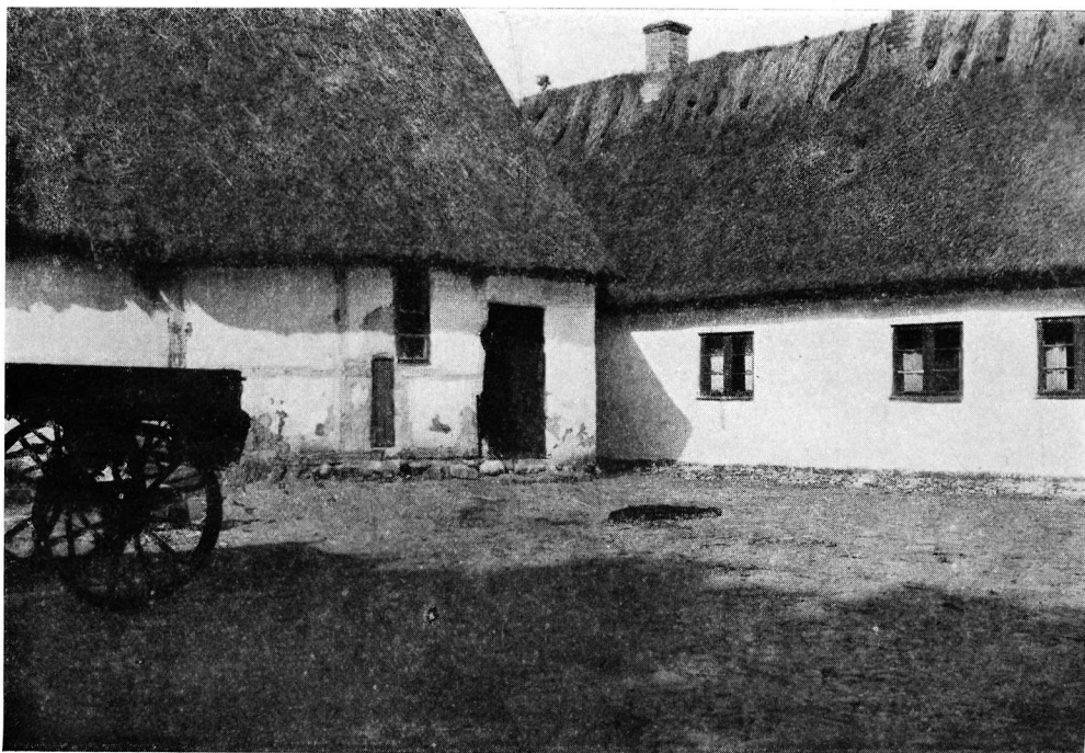
Norra längan och en del av boningslängan.
