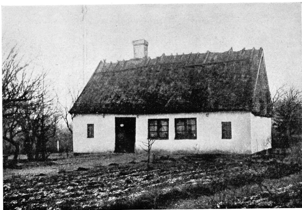
Husmanshus å Åkarp n:r 8, västra sidan.
