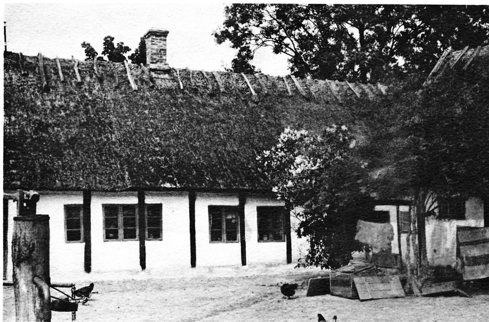
Lomma n:r 12, Lomma socken. Tillhör Alnarps lantbruksinstitut. Gårdsinteriör.
