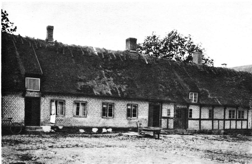
Vinstorp n:r 4, Lomma socken. Ägare: Anders Henriksson. Boningslängan från norr.
