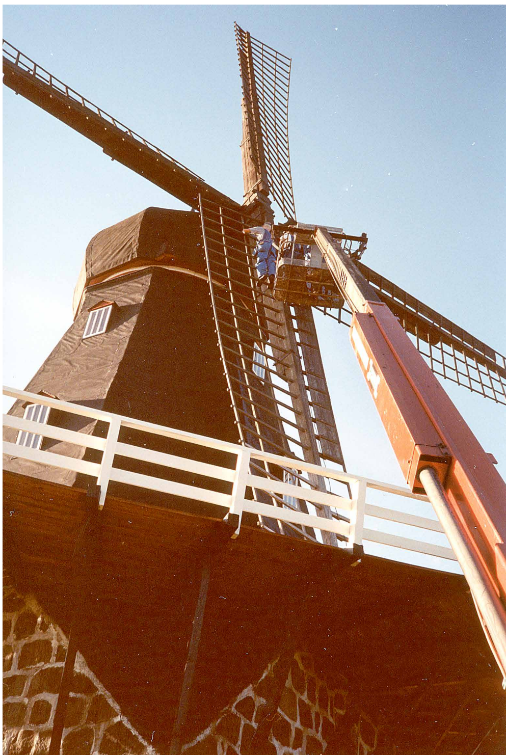
3. Förberedelser för nertagning av vingarna.
