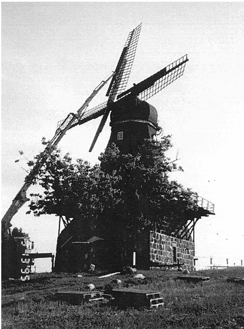
21. Kranen har vridit vingen rakt upp
