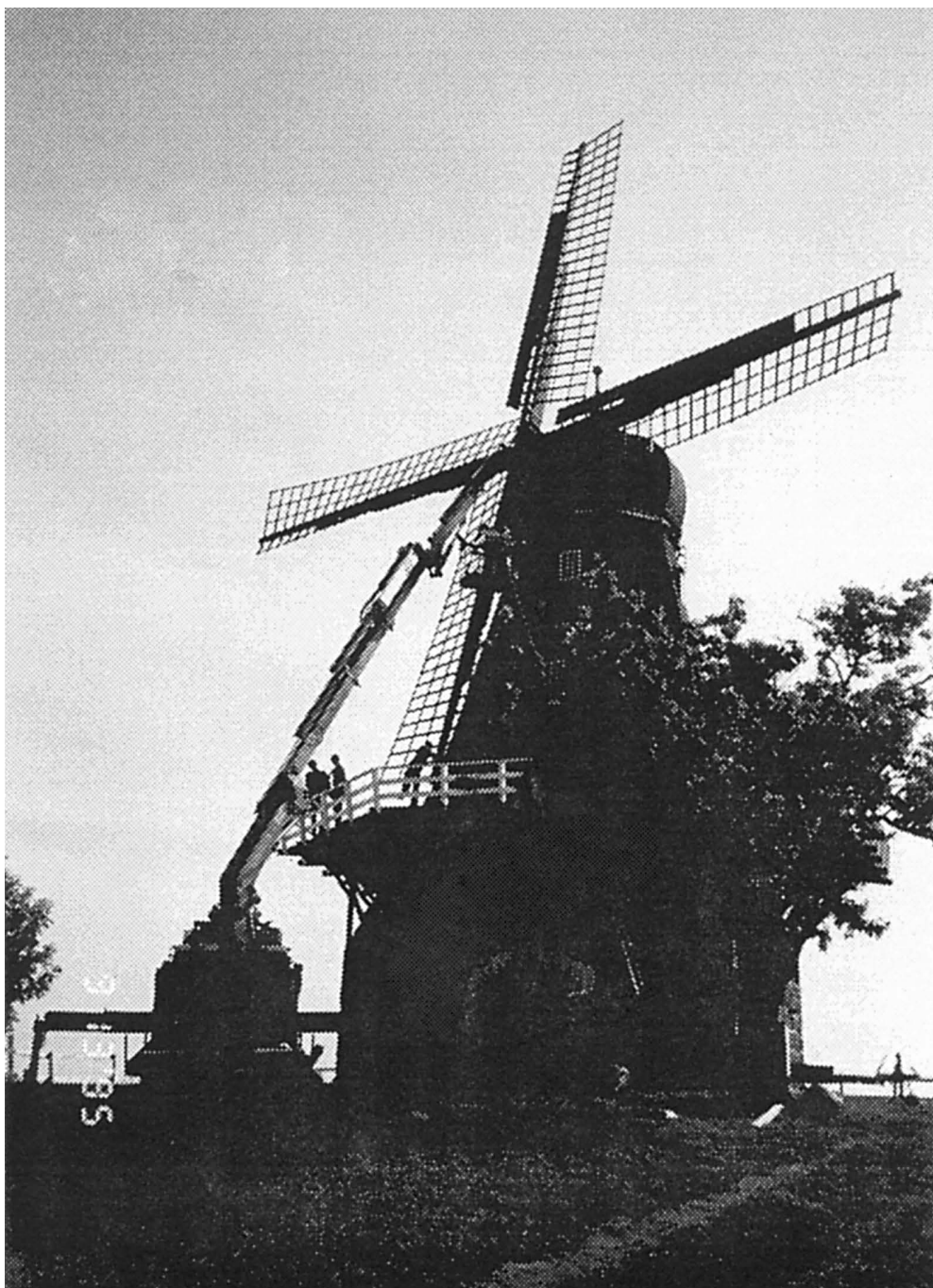
23. Andra vingen på plats och hillorna kan monteras
