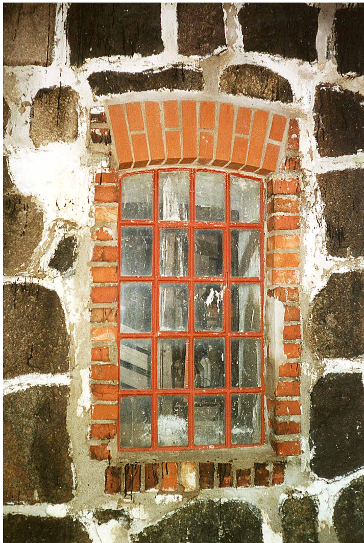
19. Nytt tegelvalv över fönster.
