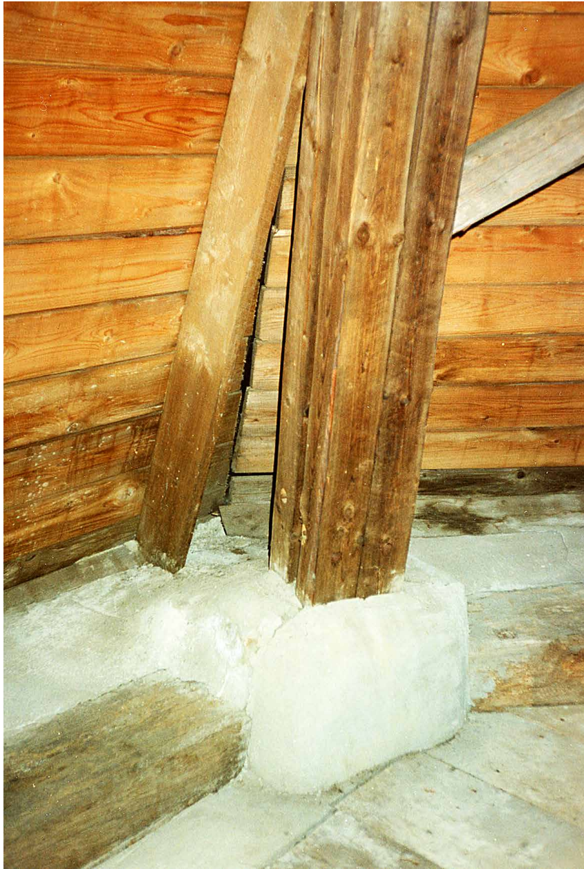
6. Cementklumpar som nedre stöd för ståndare samt cementfyllning mellan fotträ och yttervägg.
