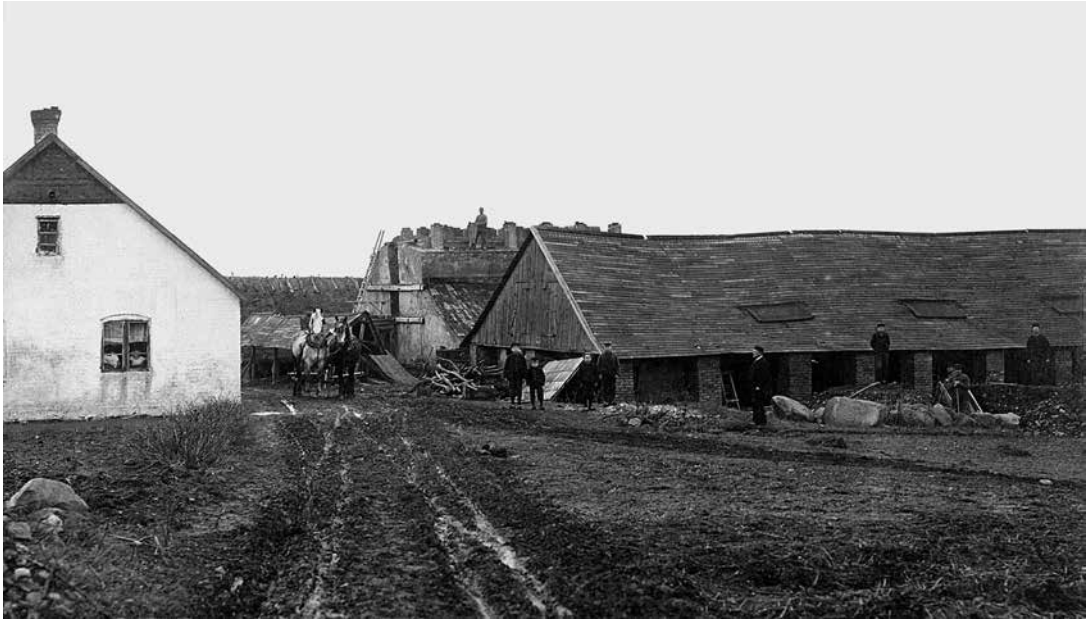
Brännugn och tegellador på Bruksgården i Vismarlöv. (L Ohlsson)
